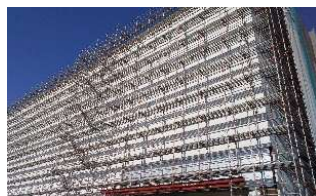
マンション工事
