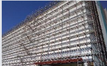
マンション工事
