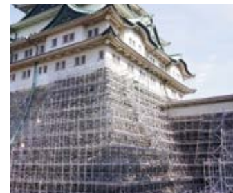
▲くさび緊結式足場現場写真
