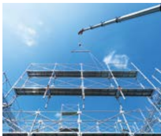
▲次世代足場現場写真
