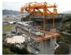
新東名高速道路 橋脚工事
