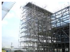
大規模倉庫 屋根成形工事
