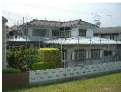
住宅建設工事
