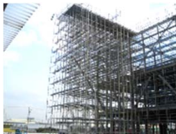
大規模倉庫 屋根成形工事
