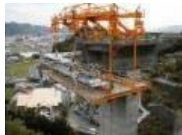
新東名高速道路 橋脚工事
