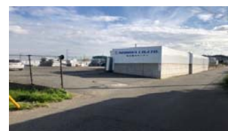
横浜機材センター
