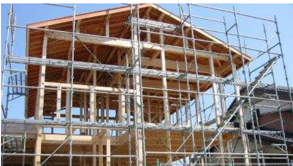
戸建住宅におけるくさび緊結式足場『シンワキャッチャー』の施工例
