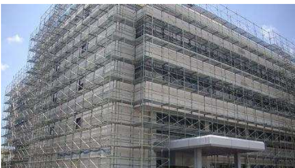
中層の建築におけるくさび緊結式足場『シンワキャッチャー』の施工例
