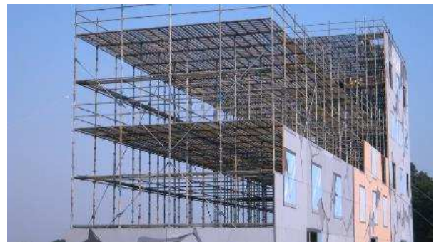
防災イベントにおける足場を用いた大規模建物の模型
