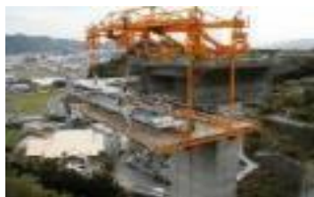
新東名高速道路橋脚工事
