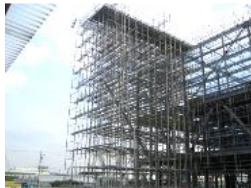
大規模倉庫屋根成形工事
