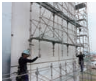
▲次世代足場現場写真
