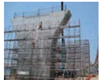
▲くさび緊結式足場現場写真
