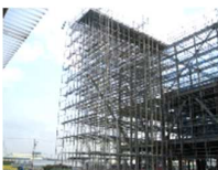
大規模倉庫 屋根成形工事
