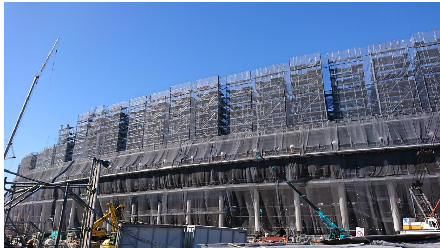
新国立競技場（建設現場）
