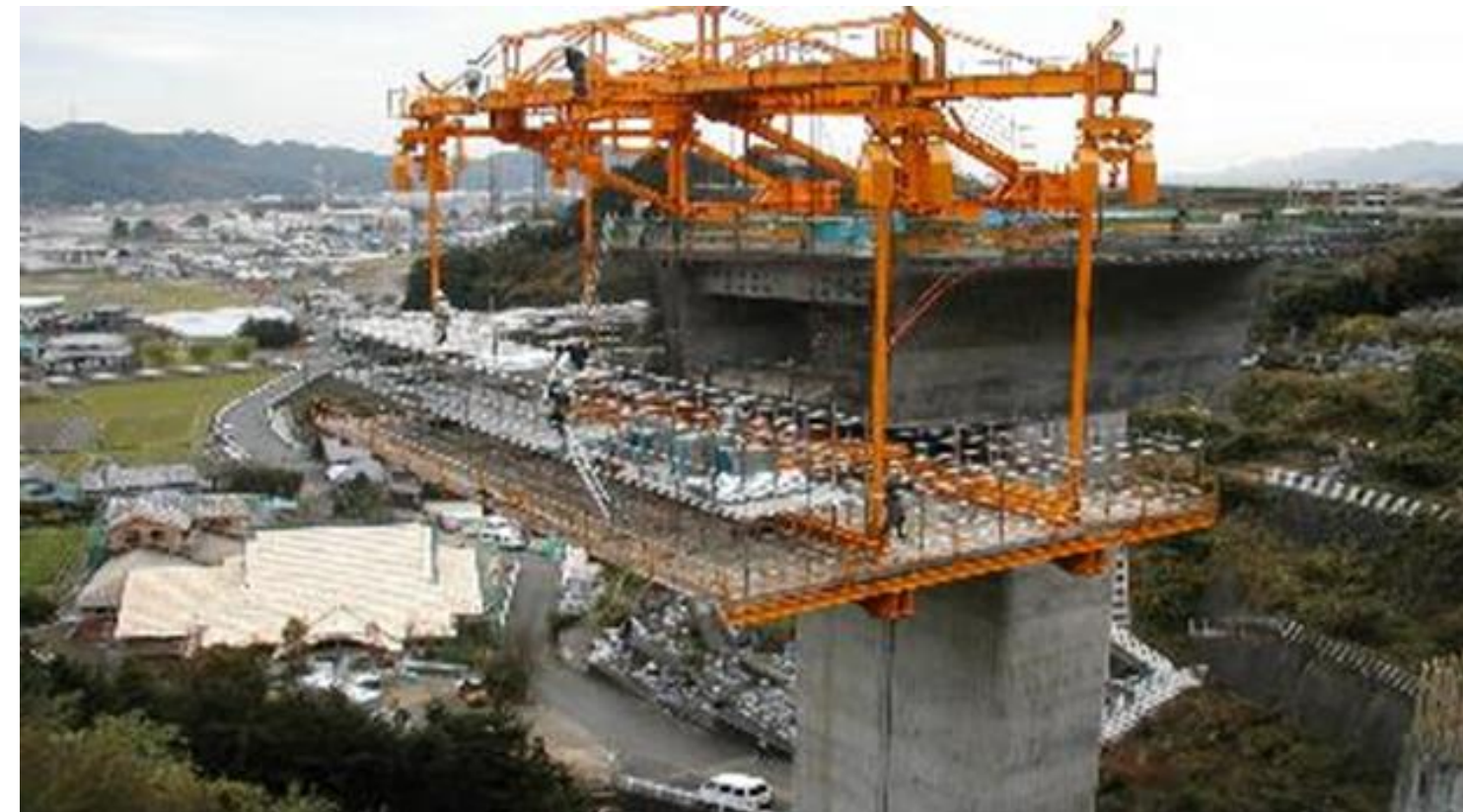
橋梁工事の様子 (イメージ)
